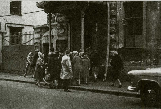
Начало рабочего дня на Московской швейной фабрике № 5. 1960-е
